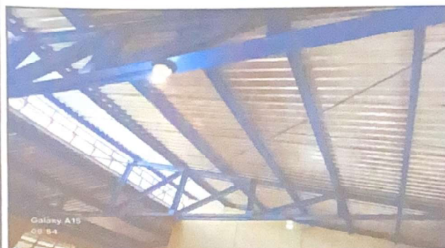
Foto 3: Se observan laminas nuevas y las costaneras son pintadas.
