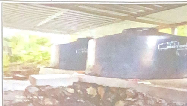
Foto 1: Mejoramiento de plancha de tinacos.
